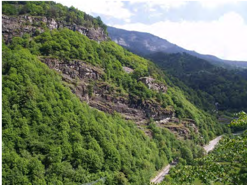
Panoramica del settore destro idrografico dell'area omogenea Iselle nord
